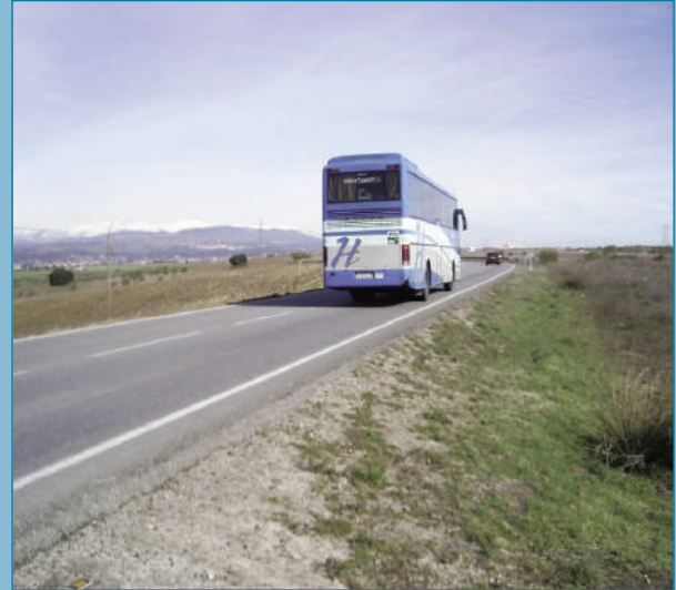
Figura 83. Arcén con anchura muy escasa.
