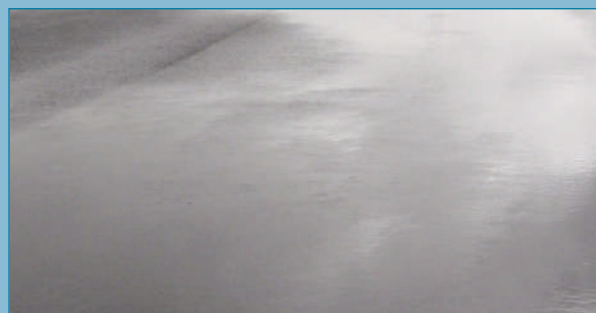
Figura 77. Drenaje superficial insuficiente.
