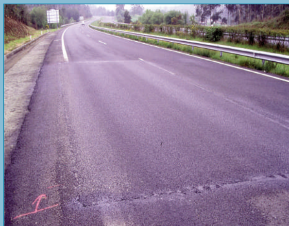
Figura 74. Reparación hasta el borde de un pavimento drenante.
