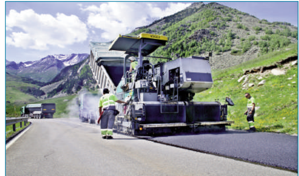
Figura 1. Extendido de una capa ultrafina
