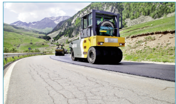
Figura 3. Extendido de una capa ultrafina sobre una superficie fisurada
