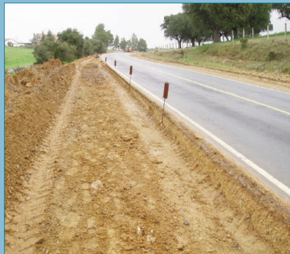
Figura 90. Obra de ensanche de plataforma.
