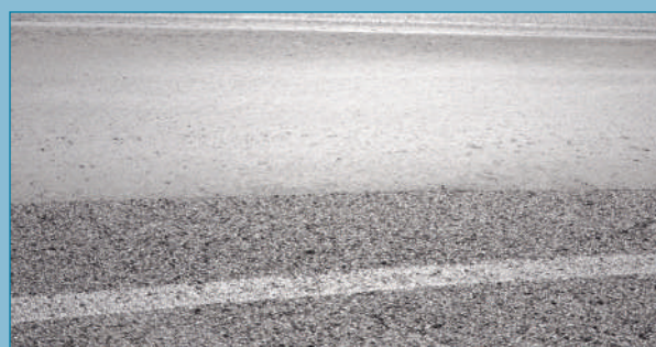
Figura 79. Pavimento deslizante por incrustación del árido grueso en el mortero de la mezcla.
