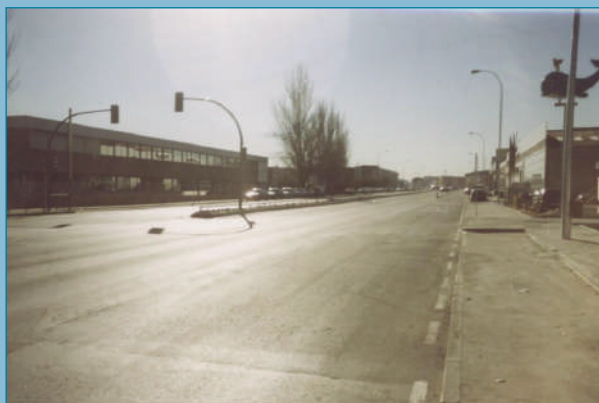
Figura 75. Pavimento que se ha vuelto deslizante.
