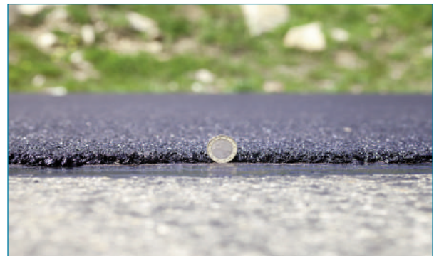
Figura 2. Detalle del espesor de una capa ultrafina
