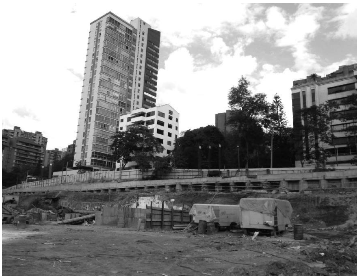
Muro de contención, Comuna 14, El Poblado, Avenida El Poblado.
