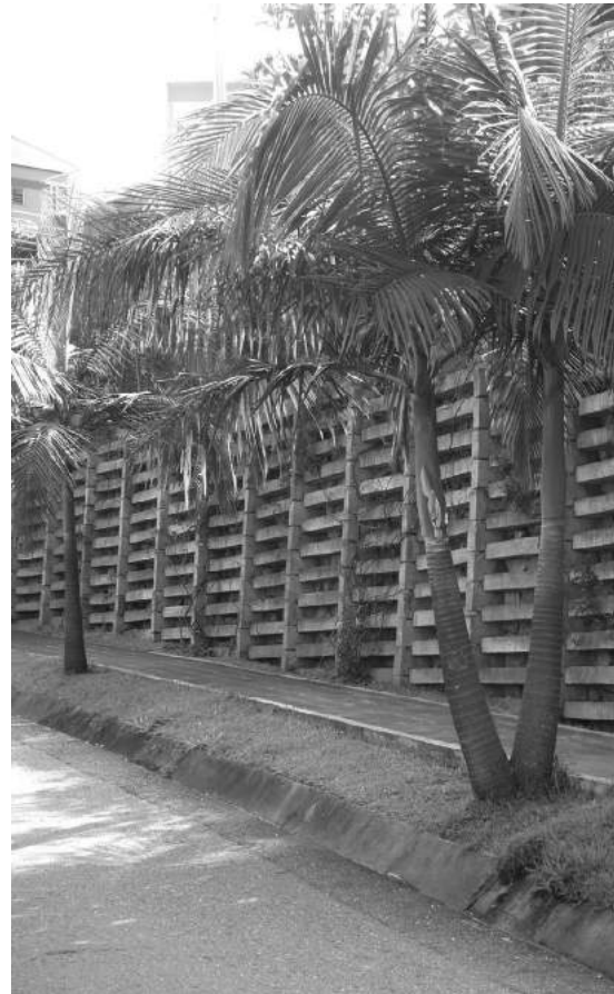
Muro en concreto tipo Criva, Comuna 14, El Poblado.
