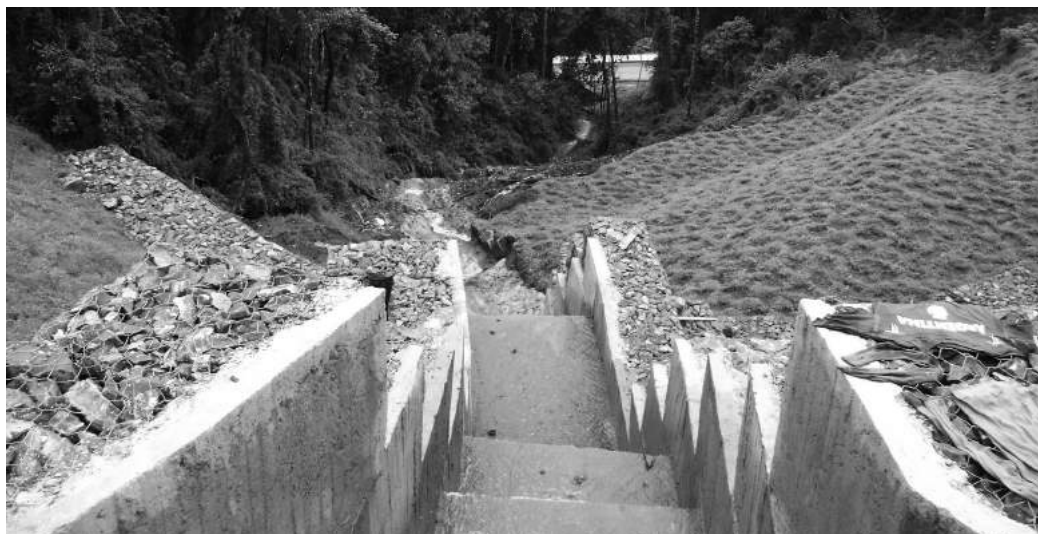
Estructura hidráulica, Quebrada La Presidenta, Vereda Las Palmas, Corregimiento Santa Elena.
