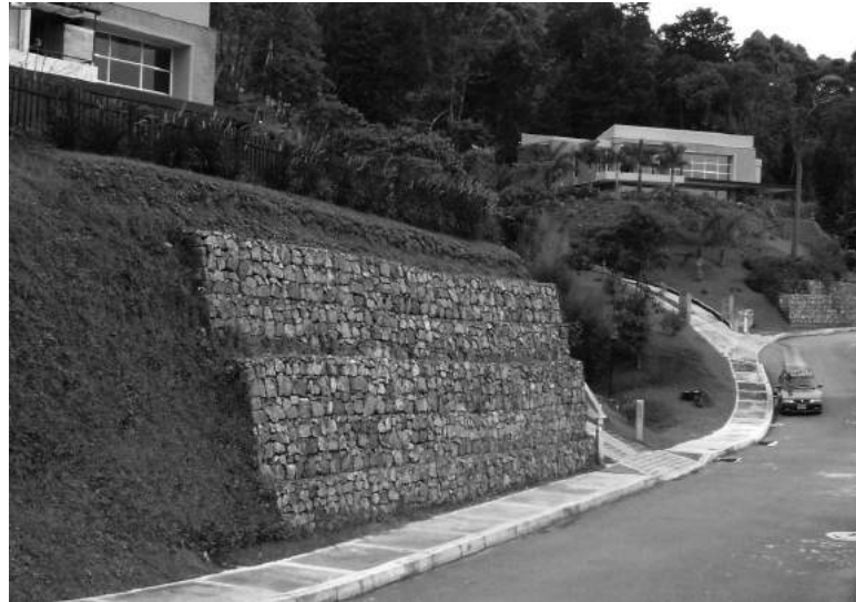
Muro en Gavión, parcelación La Palmera, vereda Las Palmas.
