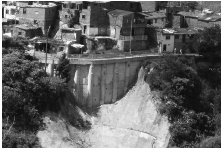
Obra de estabilización de talud, Comuna 8, Villa Hermosa, Barrio Las Miras.
