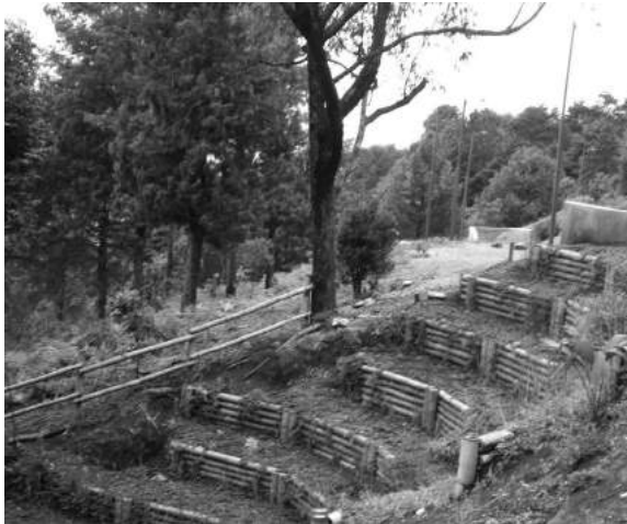
Trinchos y barreras vivas. Jardín Circunvalar. Cerro Pan de Azúcar. Corregimiento de Santa Elena.
