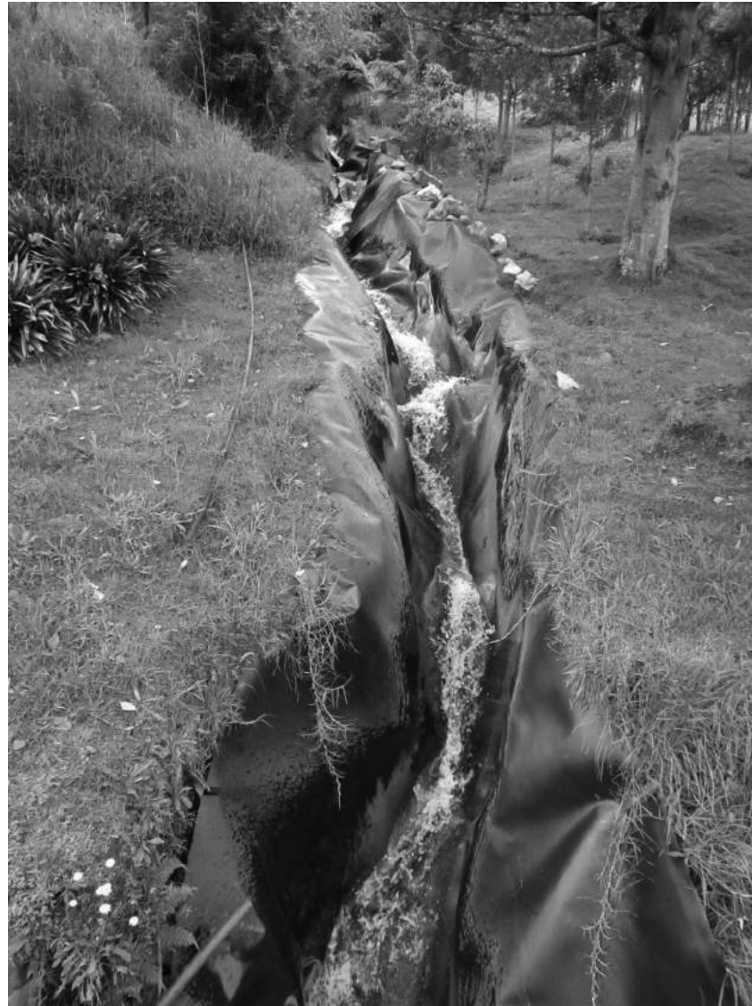
Obras de estabilización, canales interceptores, Manizales.
