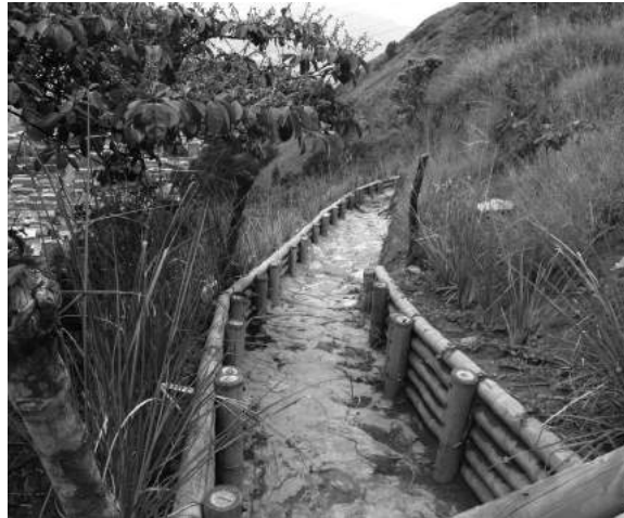
Trinchos y barreras vivas. Jardín Circunvalar. Cerro Pan de Azúcar. Corregimiento de Santa Elena.
