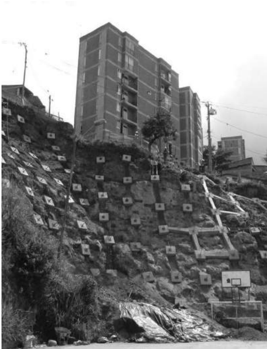
Obra de estabilización con anclajes, Comuna 2, Santa Cruz, sector La Herrera.
