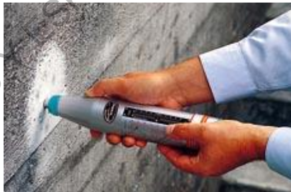
Figura 413 - 3. Superficie pulida y ensayo con el esclerómetro
