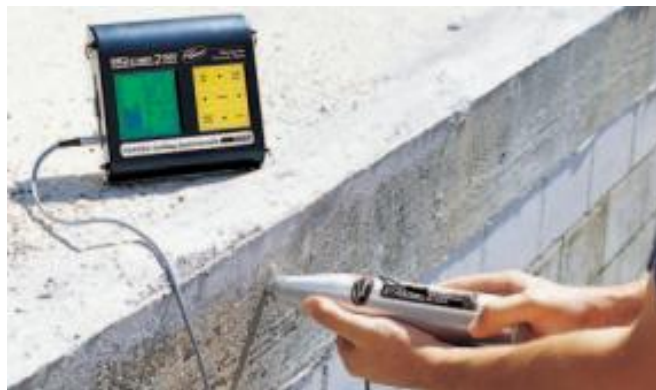
Figura 413 - 4. Ensayo con el esclerómetro
