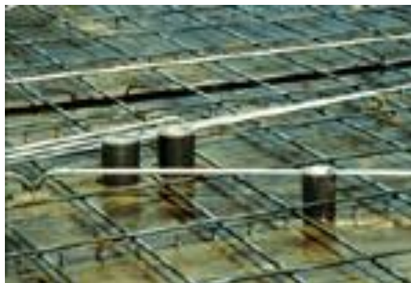
Figura 421 - 2. Moldes y elementos de soporte colocados sobre la formaleta
