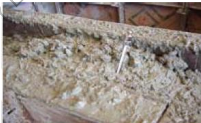
Figura 423 - 1. Determinación de la temperatura del concreto fresco entre formaletas
