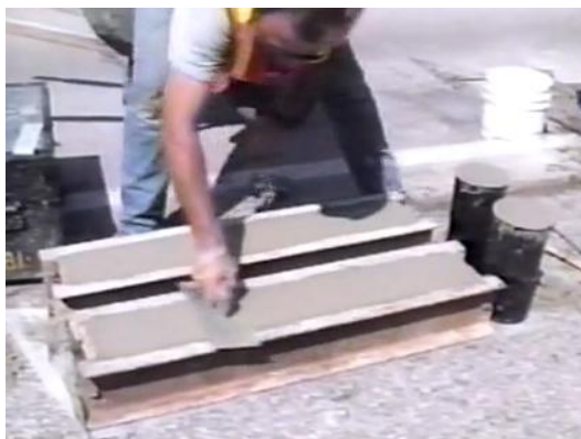
Figura 420 - 4. Enrase de una viga con la llana
