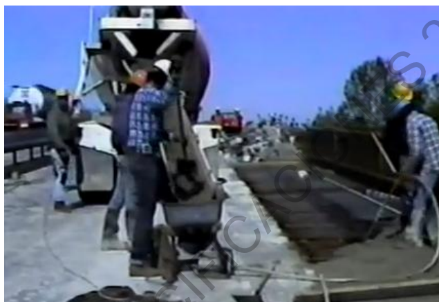
Figura 401 - 1. Toma de muestra de un camión mezclador
