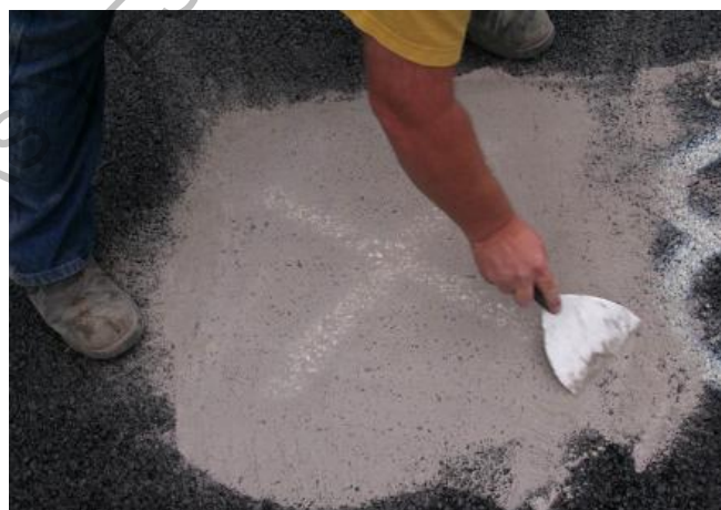
Figura 746 - 1. Nivelación de la superficie con arena
