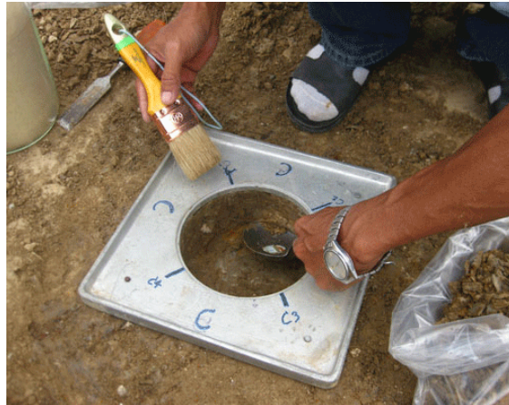
Figura 161 - 3. Excavación del hueco
